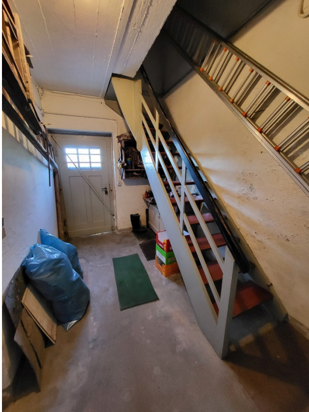
Kellertreppe, Werkstattnische und Kelleraußentür
