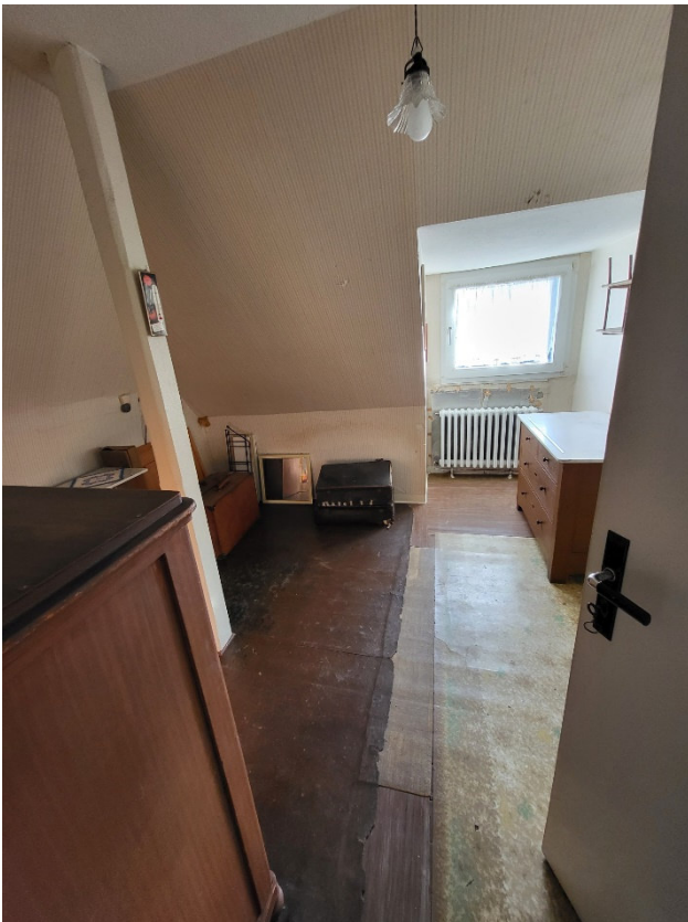
Dachzimmer, beheizbar im DG
