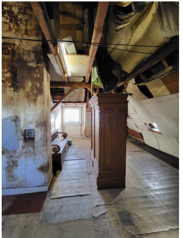
Trockenspeicher im DG
