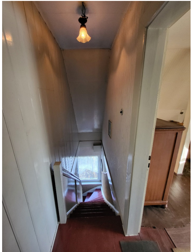
Treppenhaus vom DG zum OG
