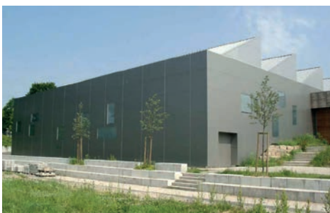
Doppelsporthalle in Hösbach
